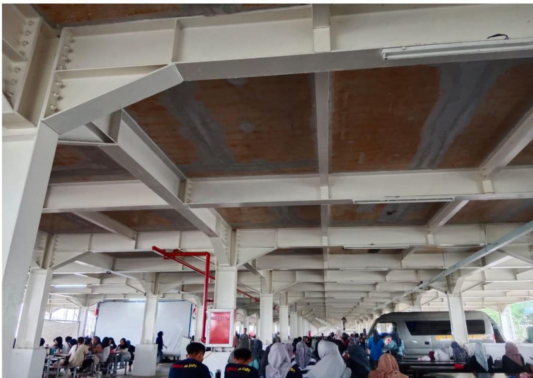
Lampiran 2. Kondisi bangunan parkir sepeda motor dan kantin
