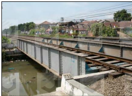
Gambar 2. 10 Jembatan Balok Pelat Girder (Sumber : Buku modul Struktur baja, Politeknik Negeri Bandung)
