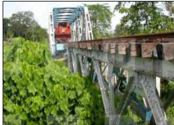
Gambar 2. 7 Jembatan Kereta Api (Sumber : Buku modul Struktur baja, Politeknik Negeri Bandung)
