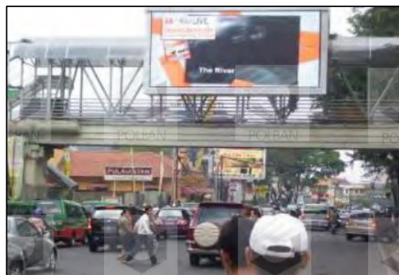
Gambar 2. 8 Jembatan Penyebrangan Orang (Sumber : Buku modul Struktur baja, Politeknik Negeri Bandung)
