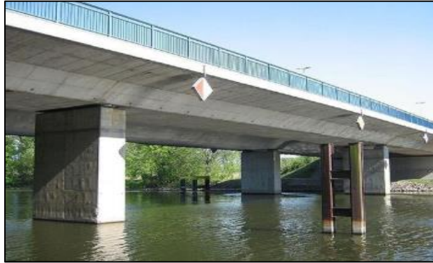
Gambar 2. 5 Jembatan Beton (Sumber : Buku modul Struktur baja, Politeknik Negeri Bandung)
