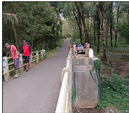
Gambar 3. 2 Jembatan Kalimas-Kajene (Sumber : Dokumentasi Pribadi)
