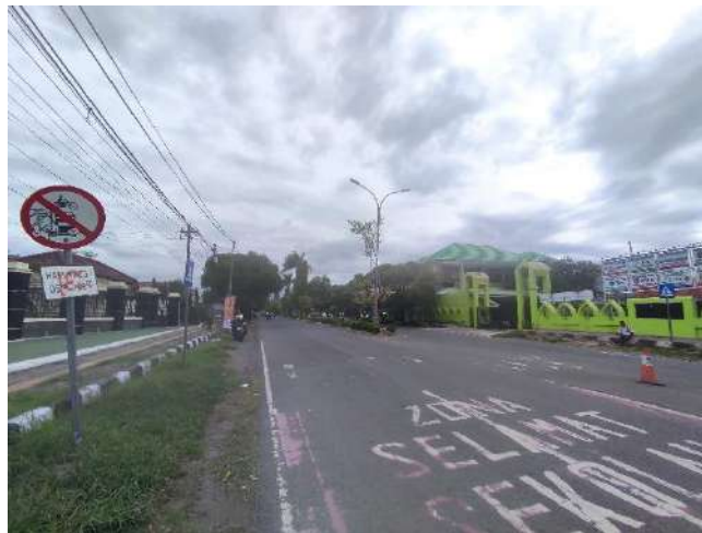
Kondisi Jalan Gajah Mada
