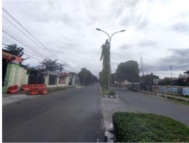
Kondisi Jalan Gajah Mada
