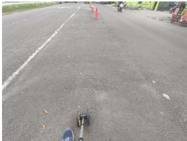
Pengukuran jarak antar tiang PJU di Jalan Gajah Mada menggunakan Walking Measure
