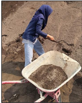
Gambar 19. Pengambilan material untuk campuran beton
