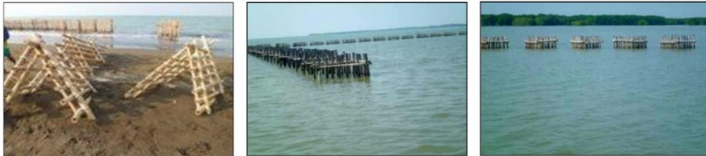
Gambar 3. Peredam gelombang dari bambu dan penataannya di perairan pantai
