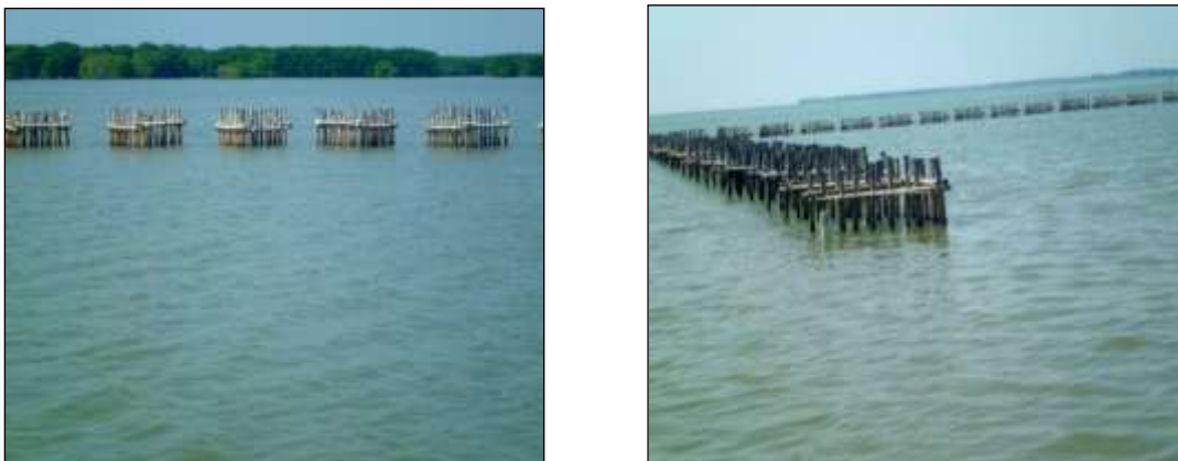
Gambar 2. Pemasangan pemecah gelombang hybride engineering
