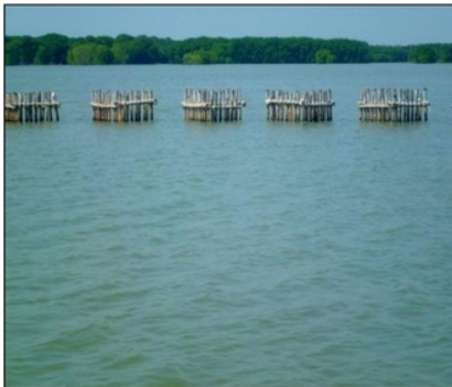
Gambar 2. Pemasangan pemecah gelombang hybride engineering
