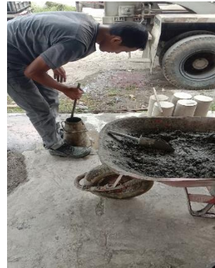
Tuangkan 1/3 bagian adonan beton segar lalu ditumbuk sebanyak 25 kali
