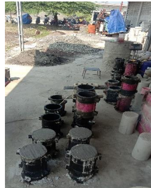
Setelah 24 jam beton akan mengeras
