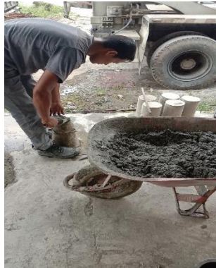
Setelah beton segar sudah jadi lanjut proses uji slump
