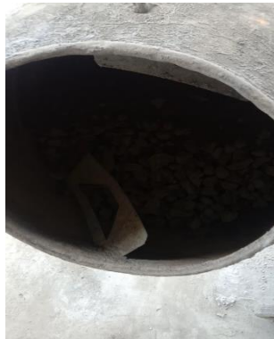
Masukan Split dan pasir kedalam mesin molen lalu di jalankan +- 5 mnt
