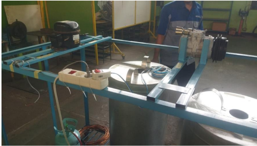
Proses Pemasangan Kelistrikan Mesin ORC
