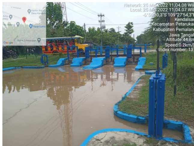
Gambar 2.4 Bangunan Bagi Dan Sadap
