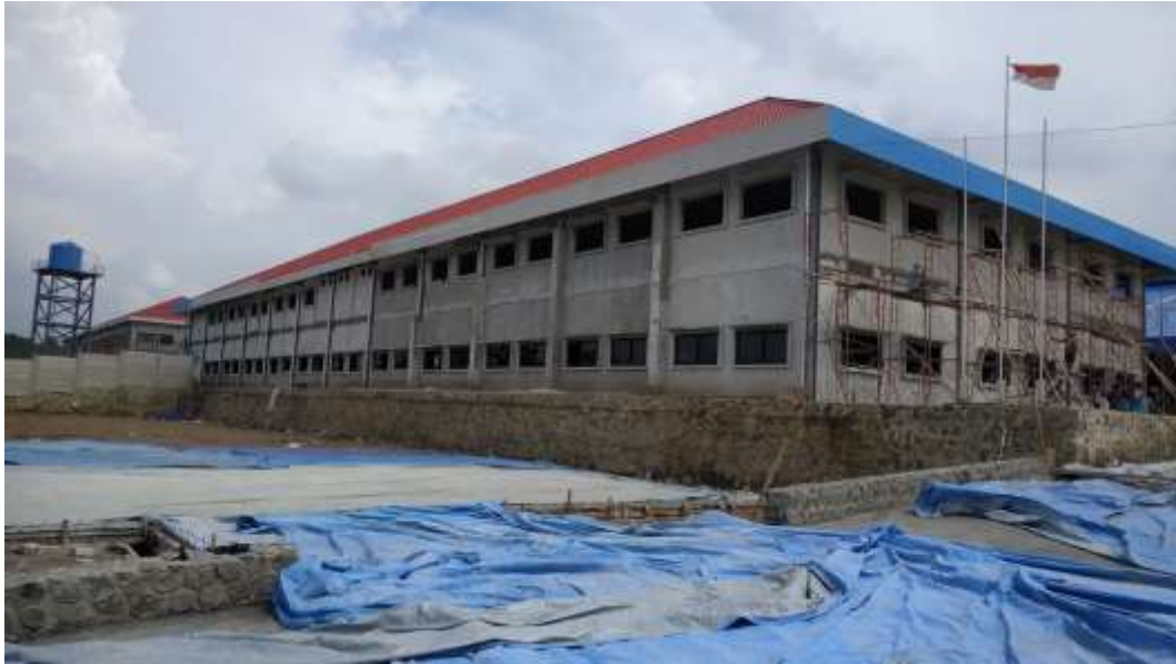
Gambar 1.1 Konstruksi gedung Office PT. Leea Footwear Indonesia (Sumber: Pribadi)
