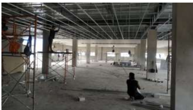
Foto pemasangan plafond
