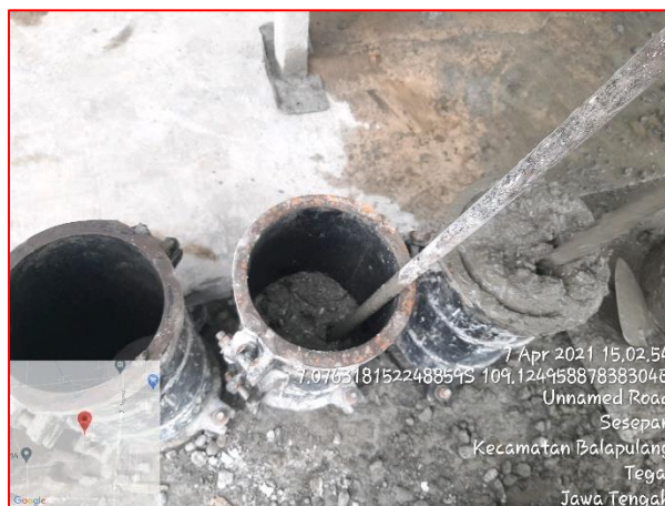
Proses Penumbukan Beton Segar Cetakan
