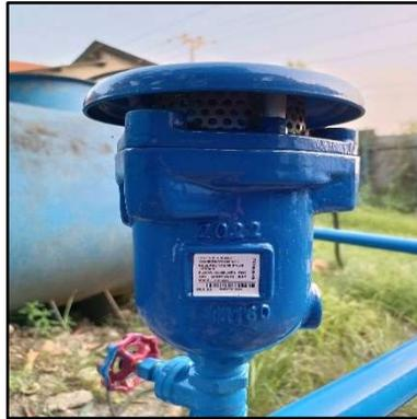
**Gambar 2.23 Katup Udara (*Air Valve*)**
