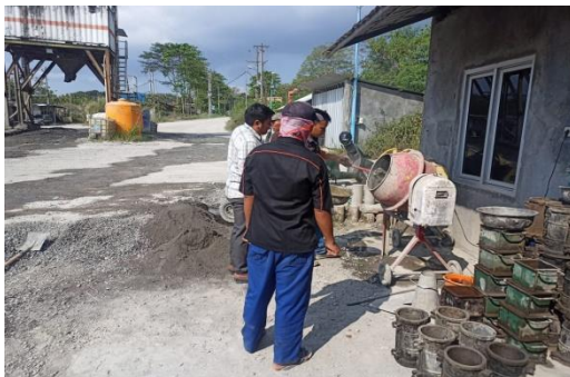
33. Kontrol slump Beton
