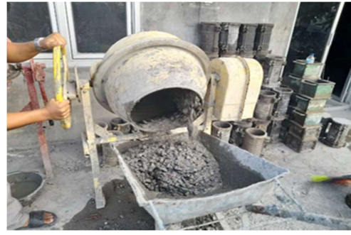
28. Penuangan Beton
