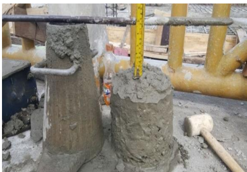
25. Slump Test Beton Segar
