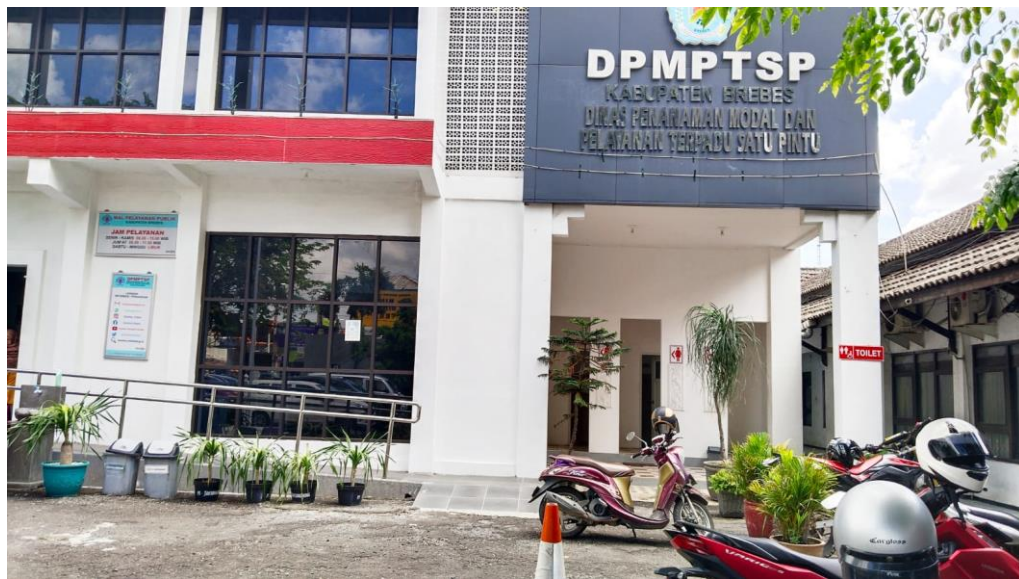
Akses jalan untuk pengguna kursi roda yang sudah dilengkapi ram, Di Pusat Mal Pelayanan Publik Kabupaten Brebes, Foto diambil pada Tanggal 21 September 2023
