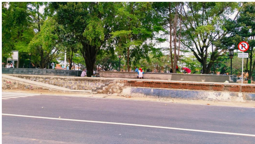
Akses jalan menuju area pertamanan alun-alun Kabupaten Brebes yang sedang dalam tahap Pembangunan untuk pengguna kursi roda menuju, Di Alun-alun Kabupaten Brebes, Foto diambil pada Tanggal 21 September 2023
