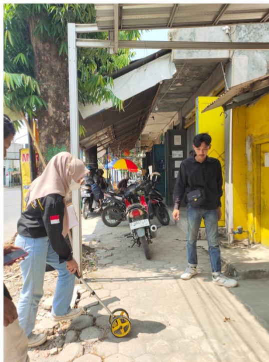
Gambar 8. Pengukuran Bahu Jalan
