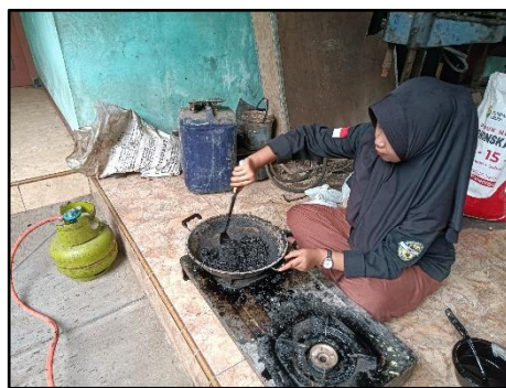
Gambar 3. 78 Memasak Campuran Aspal Panas (Sumber : Dokumentasi Pribadi)
