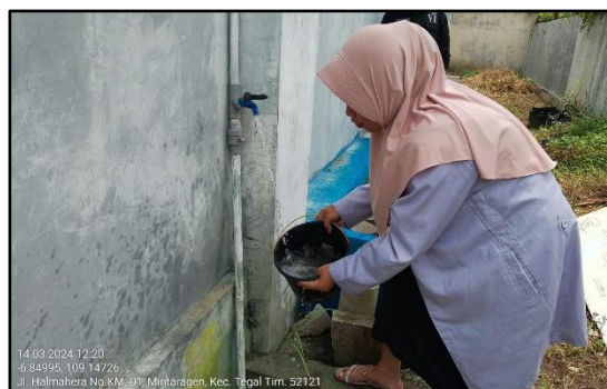
Gambar 3. 32 Mencuci Agregat (Sumber : Dokumentasi Pribadi)
