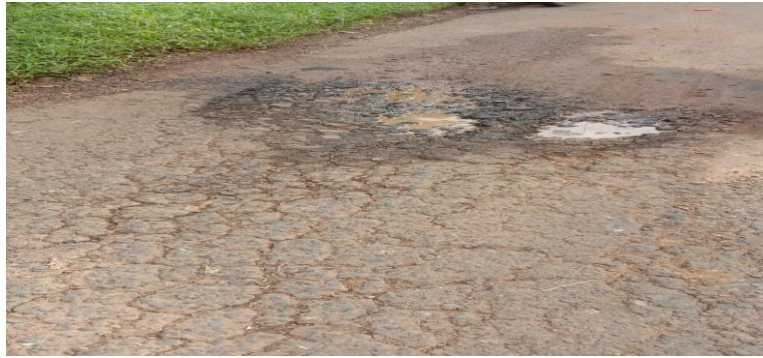
Gambar 2.8 Retak Slip
