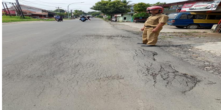
Gambar 2.4 Retak Kulit Buaya
