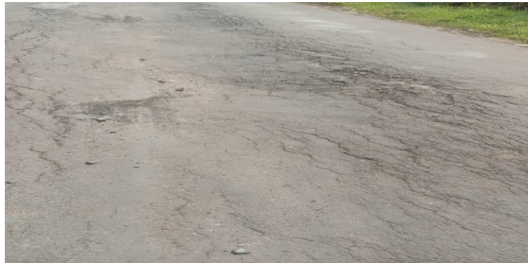
Gambar 2.7 Retak Susut
