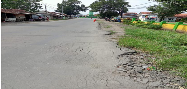
Gambar 2.5 Retak Pinggir
