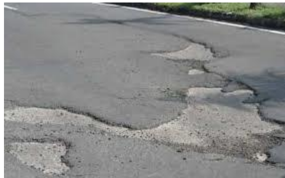
Gambar 4.18. Pengelupasan Lapis Permukaan
