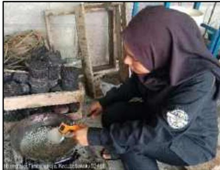
**Gambar 3.51** Tahap Pemanasan Agregat
