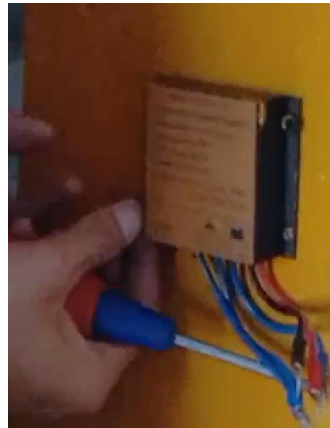
Gambar Pemasangan Wind Controler
