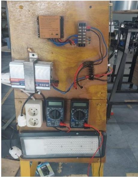
Gambar Proses Pemasangan komponen
