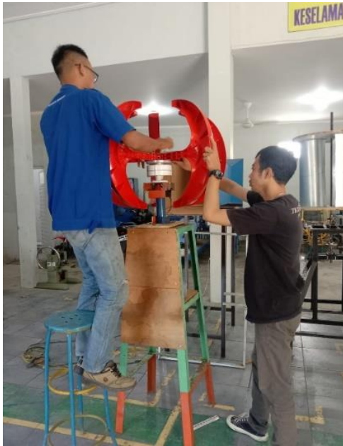
Gambar Pemasangan Baling-baling Turbin
